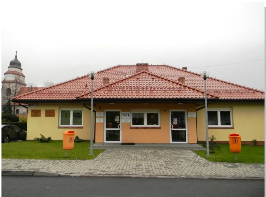
Budynek ośrodka zdrowia
